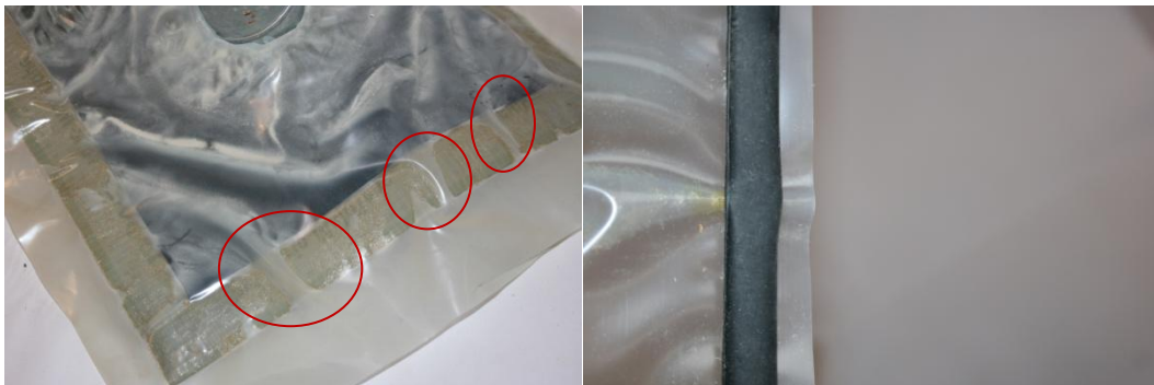
Figur 16. Luftkanaler i stostejp (t.v.) och syllisolering (t.h.).
