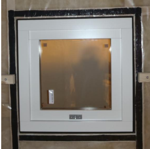
Figur 9. Plastfolien fästes i reglarna kring fönstren med klisterremsa av butyl.
